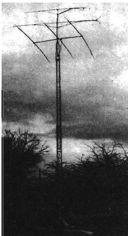
Figura 11.16. Un mástil autoportante y sus tres antenas giratorias accionadas por el mismo motor.
