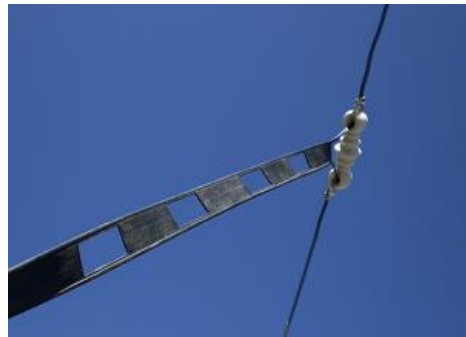
Figura 18 - fotos de K4ICY e WB0JNR – isolador central para dipolo
