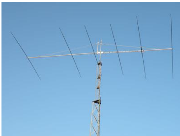
Figura 20 - Yagi de 6 elementos: quatro diretores e um refletor. O dipolo principal é o segundo, da direita para esquerda. Note o tamanho da "gondola" que sustenta os dipolos: 8m – dois veículos em linha
